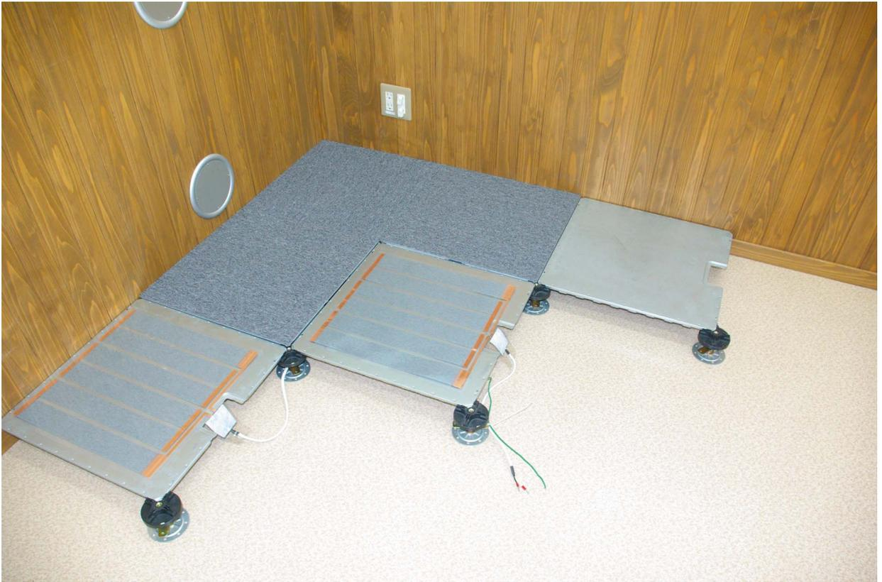
※再度、「電源線床下落とし込み部」の端子部やケーブルが、OAフロアユニットと干渉しないかを確認してください。
