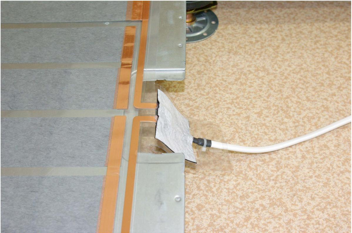
②配置したヒーターパネルに識別のためナンバリングなどを行ってください。
